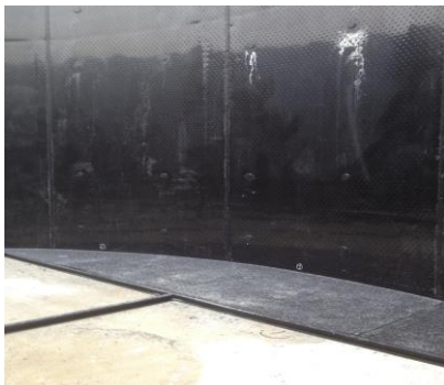
Figure 26. Pose sur profilé PE
