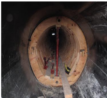
Figure 45. Coffrage du PEHD
