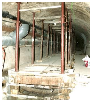
Figure 49. Pose du PEHD
