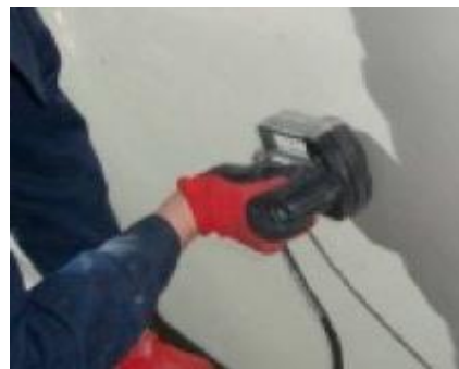
Figure 13. Soudure par induction
