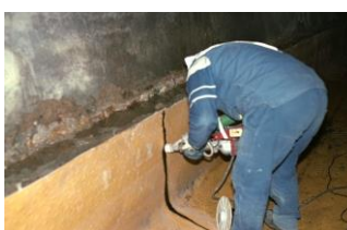
Figure 52. Soudure par extrusion
