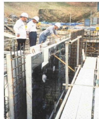
Figure 55. Pose du voile
