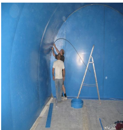
Figure 6. Étanchéité en voûte
