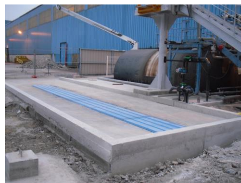
Figure 41. Vue de l'ouvrage achevé
