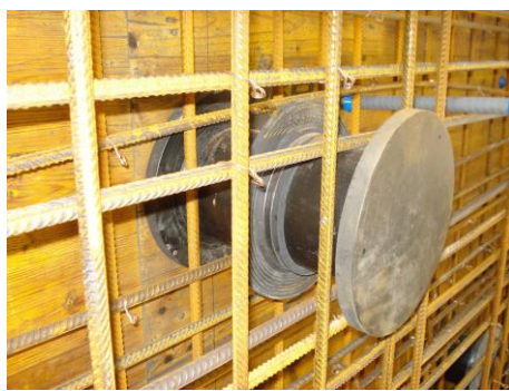
Figure 31. Traversée de paroi
