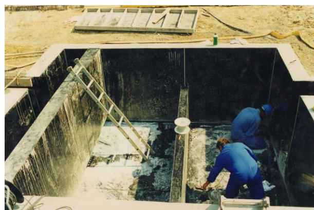
Figure 34. Soudure des voiles
