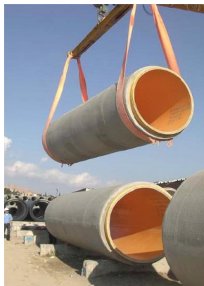
Figure 53. Tuyau chemisé Figure 54. Voiles béton avec l'étanchéité
