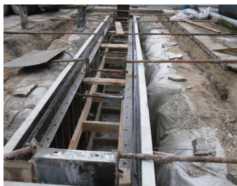
Figure 39. Maintien du coffrage
