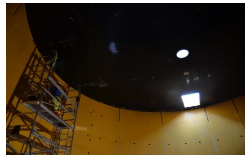
Figure 29. Vue en sous-face d'un digesteur
