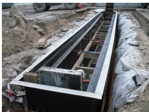
Figure 38. Coffrage intérieur
