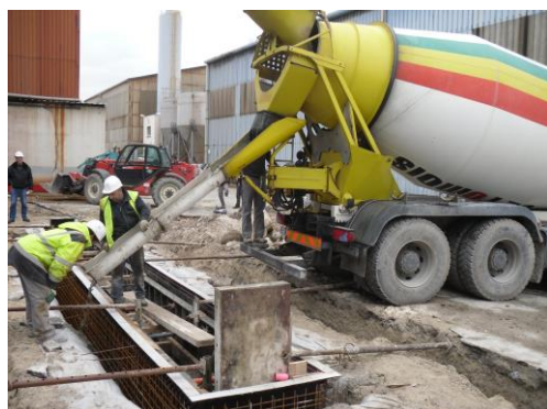
Figure 40. Coulage des voiles
