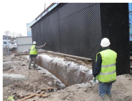
Figure 37. Pose de l'ouvrage
