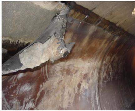
Figure 43. Étanchéité en plomb
