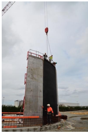
Figures 24 et 25. Pose du panneau d'étanchéité sur le coffrage
