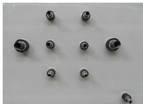
Figure 15. Raccordement sur traversées
