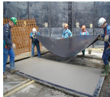
Figure 27. Pose de l'étanchéité sur un béton frais
