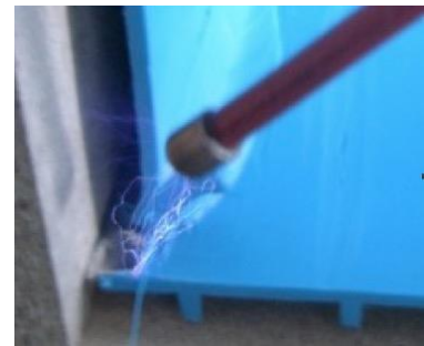
Figure 3. Contrôle des soudures
