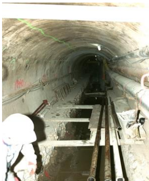
Figure 48. Préparation du support
