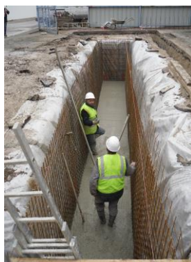
Figure 36. Coulage du radier
